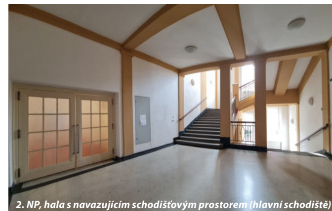
2. NP, hala s navazujícím schodišťovým prostorem (hlavní schodiště)
