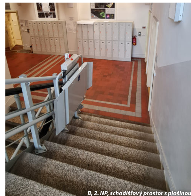
B, 2. NP, schodišťový prostor s plošinou
