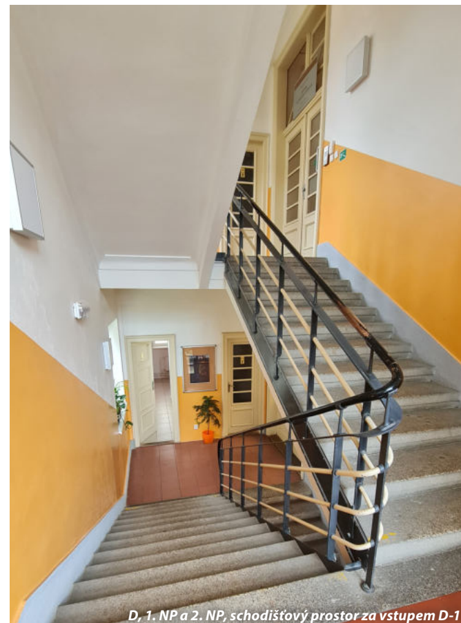
D, 1. NP a 2. NP, schodišťový prostor za vstupem D-1
