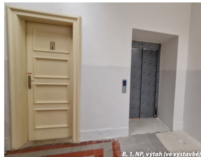
B, 1. NP, výtah (ve výstavbě)
