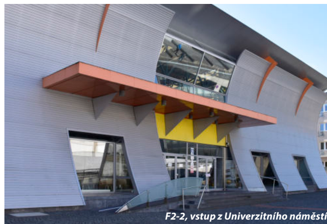
F2-1, hlavní vstup z ulice Husova
