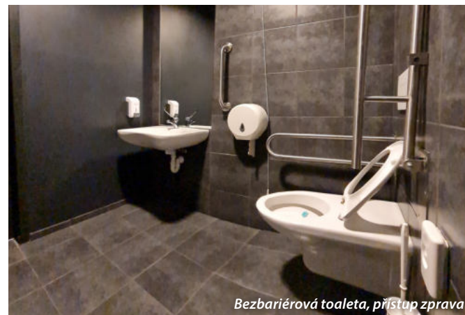
Bezbariérové WC (2. NP, sekce B)
