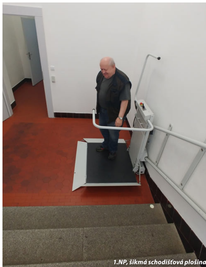
1.NP, pohled na šikmou schodišťovou plošinu
